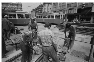
Bauarbeiter beim Bellevue, um 1962. Fotografie: Hans ... © ETH-Bildarchiv, Zürich.
